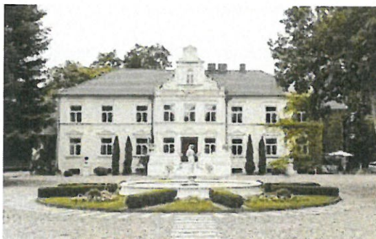
Dwór w Kalinowej (Wpis do Rejestru Zabytków nr 434/236/A) Fotografia 7. Widok na dwór w Pstrokonjach.
